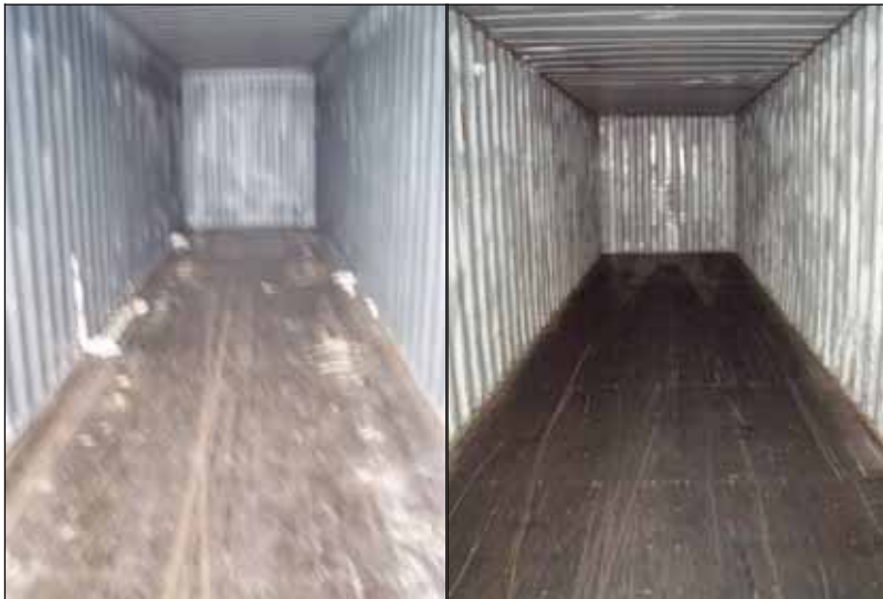
Abb. 35: Container vor (li.) und nach der Reinigung (re.)
